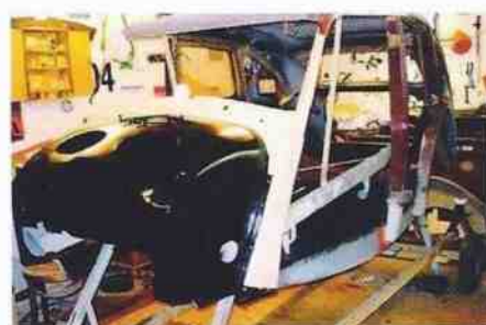
Het vernieuwen van het houtwerk
